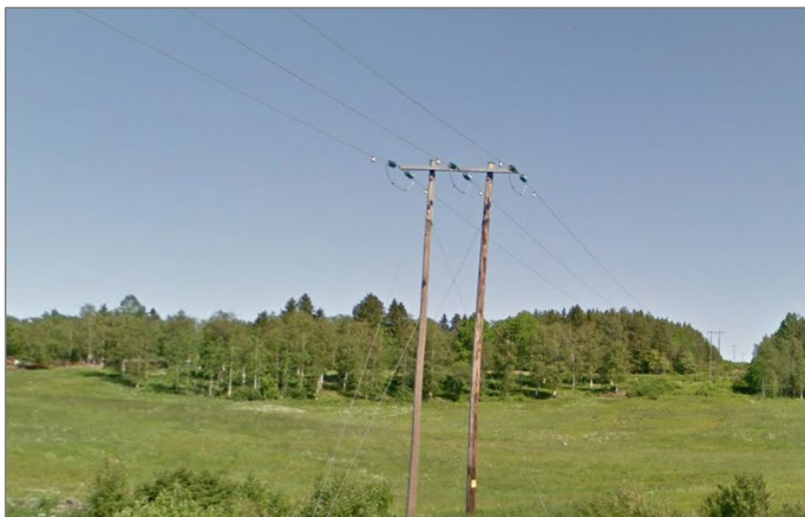
Figur 5. Landskap runt befintlig luftledning AL19.
