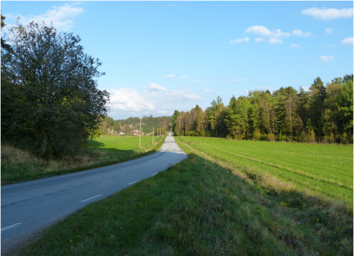
Ledningen syns mot skogskanten
