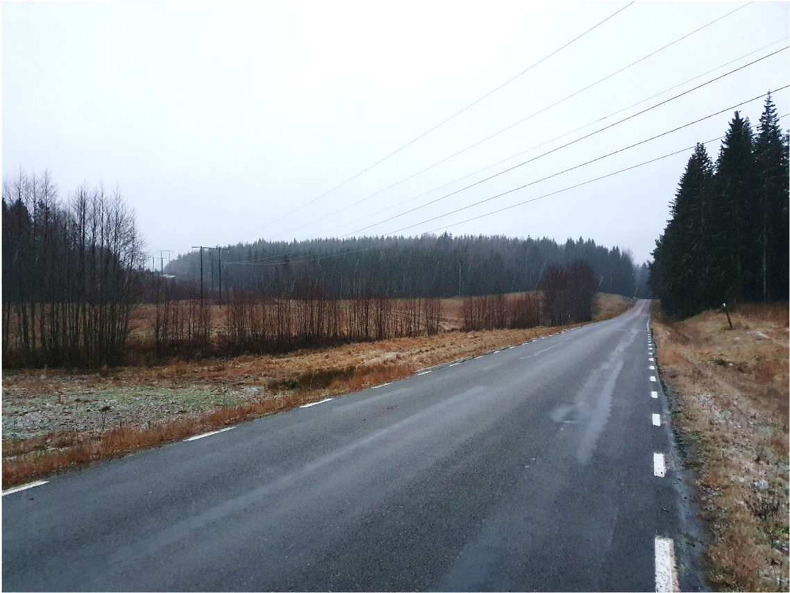
Figur 6. Korsning av väg 669, Ellevios ledning är den närmast i bild. Parallellgående tillhör Vattenfall Eldistribution.
