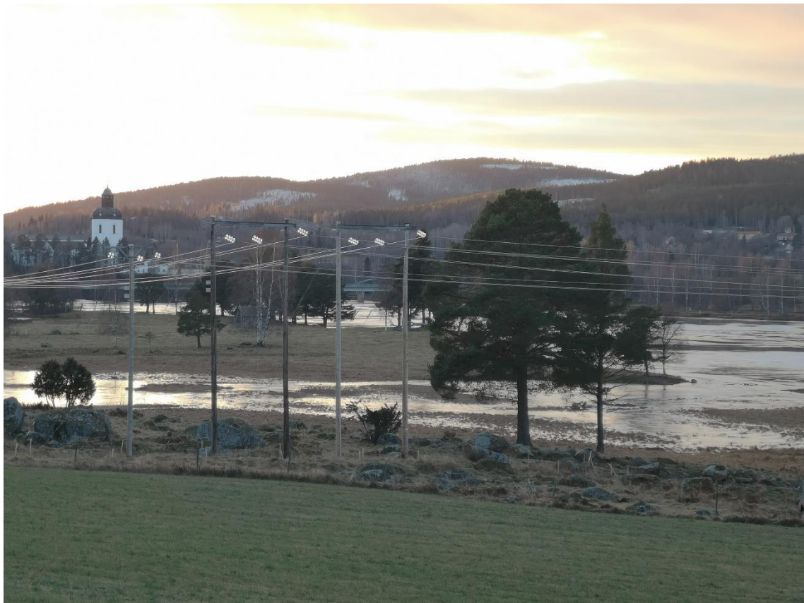
Bild 5. Järvsö kyrka i bakgrunden till ledning AL22. Denna del av ledningen ligger inom riksintresseområde Järvsö centralbygd. Parallellt med ledning AL22 i bild återfinns ledning AL13 som avses rivas.
