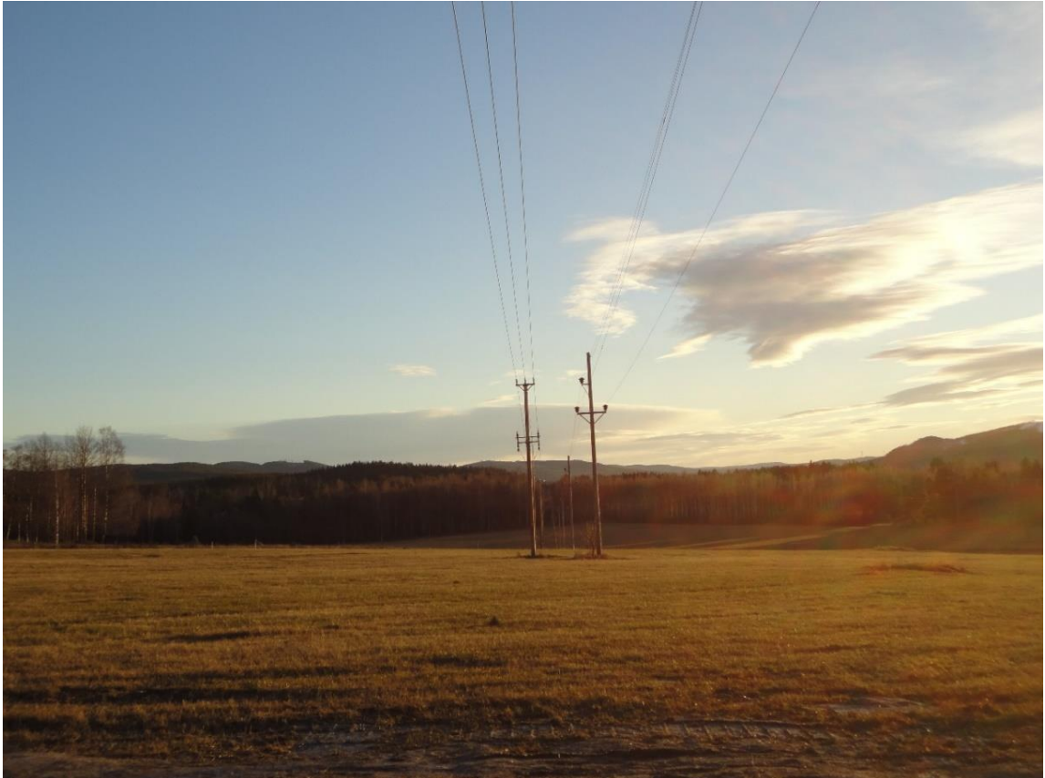
Bild 1. Foto över befintlig ledning AL15 (till höger i bild) utformad som enbent trästolpe med triangelformade faslinor. Till vänster i bild sträcker sig en lokalnätsledning.
