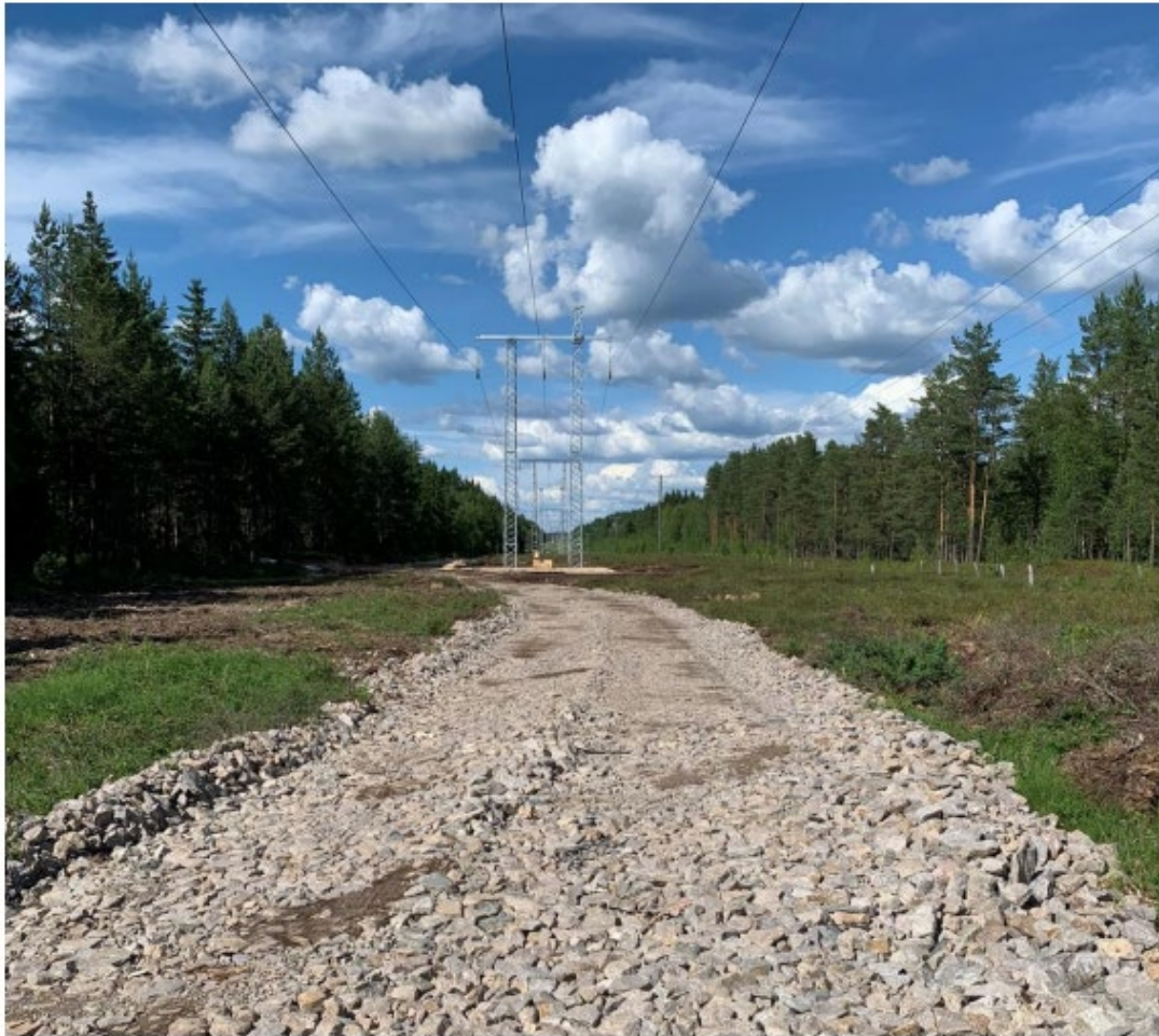
Figur 11. Exempel på anlagd arbetsväg i skogsmark för tyngre transporter i ett ledningsprojekt med stålstolpar (portalstolpar i stål).
