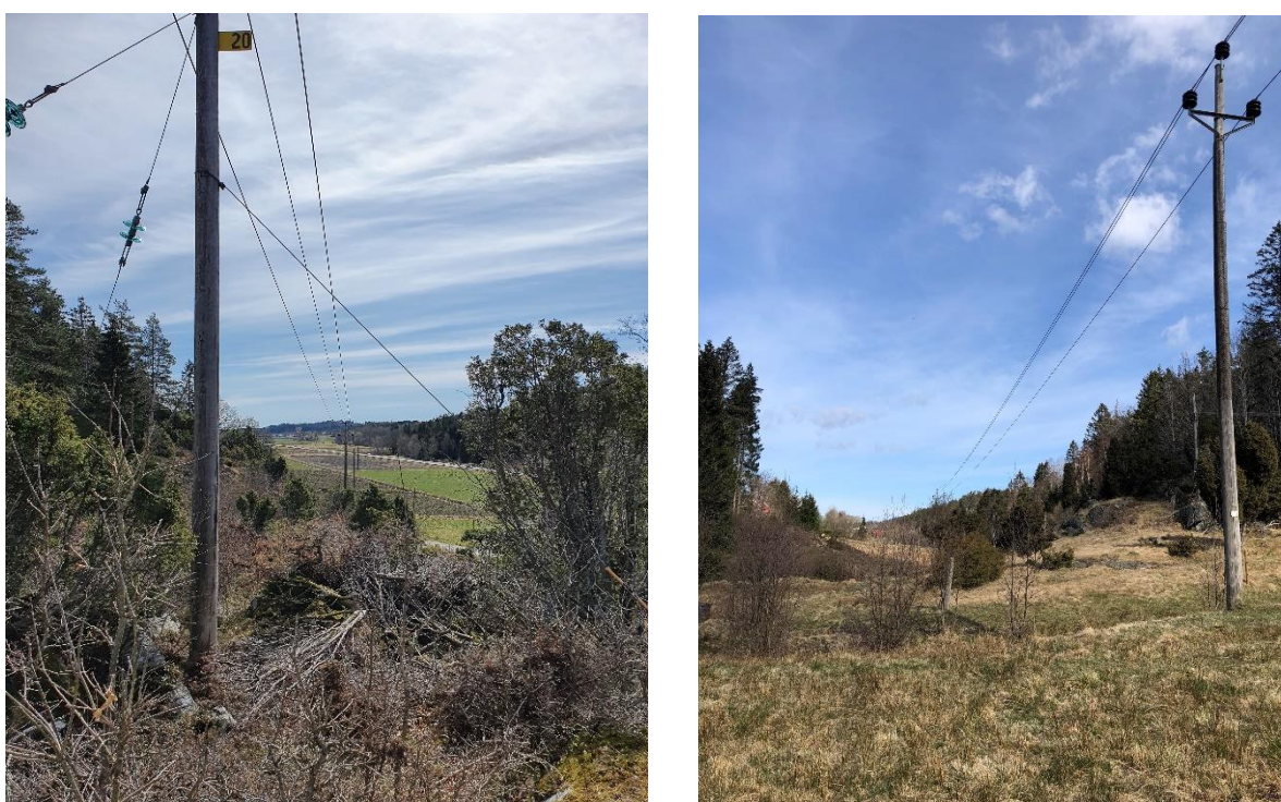
Figur 8. Vänster foto: befintlig ledning TL3 på en bergsklack (till vänster i bild) och Vräländslätten (jordbruksmarker) i bakgrunden. Höger foto: befintlig ledning TL3 inom en dalgång med skogsbeklädda dalsidor.
