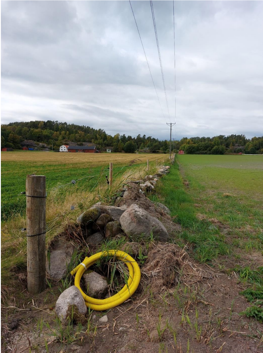
Figur 28. Exempel på stenvall på sträckan mellan Almösund och Myggenäs station.
