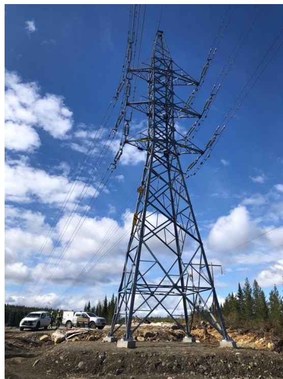
Figur 14. Exempelbild föreställande en vinkelstolpe i stål. Observera att bilden visar en stolpe med duplex-linor. I aktuellt projekt kommer enbart en lina per fas att användas.
