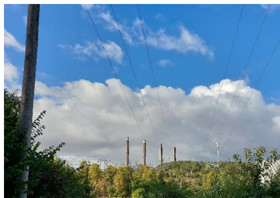
Figur 33. Vy över Vetteberget och de fyra skorstenarna, sett från Kläpps återvinningscentral.
