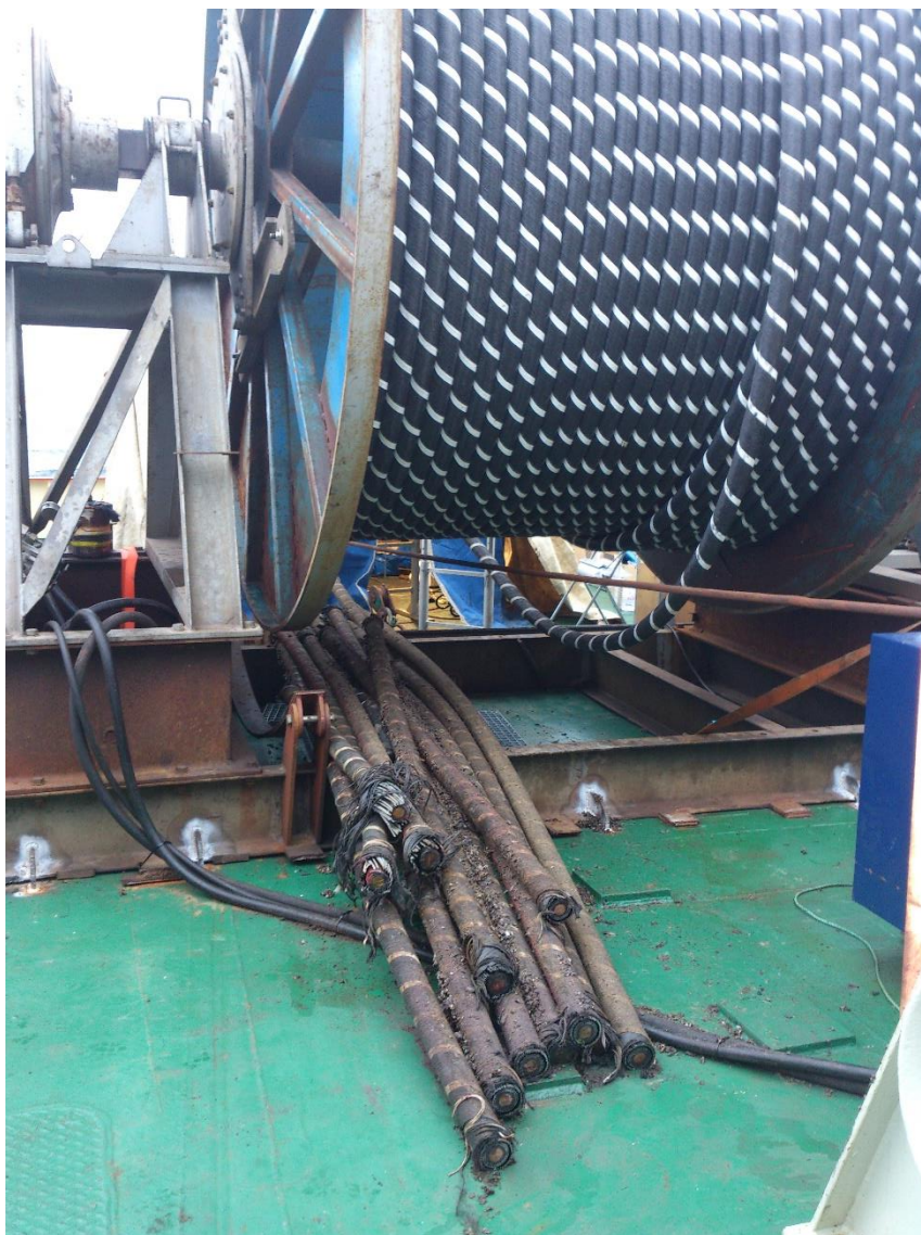
Figur 18. Exempelbild på förläggning av sjökabel. Notera att kabeln på bilden har en betydligt mindre ytterdiameter än de kablar som är aktuella i föreliggande ärende.
