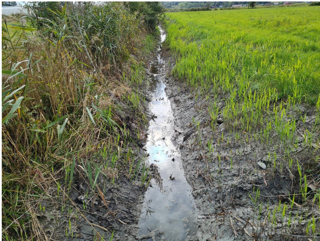
Figur 27. Dike i höjd med Myggenäs station.
