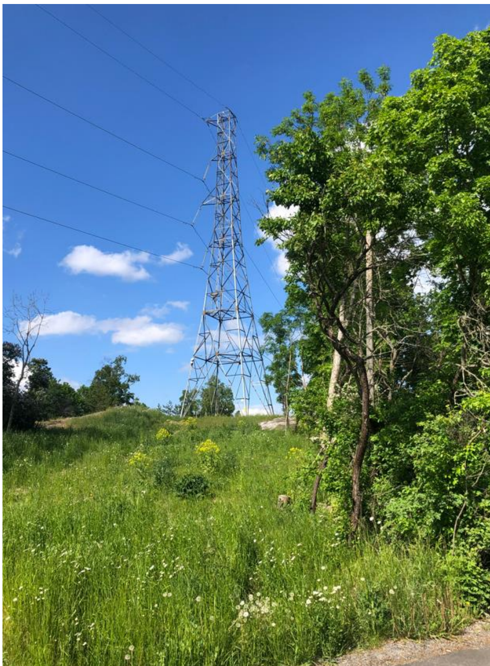
Figur 6, fackverksstolpe strax söder om skarvpunkt Örby. Foto taget från cykelvägen norr om bostadshusen längs Bjulevägen.
