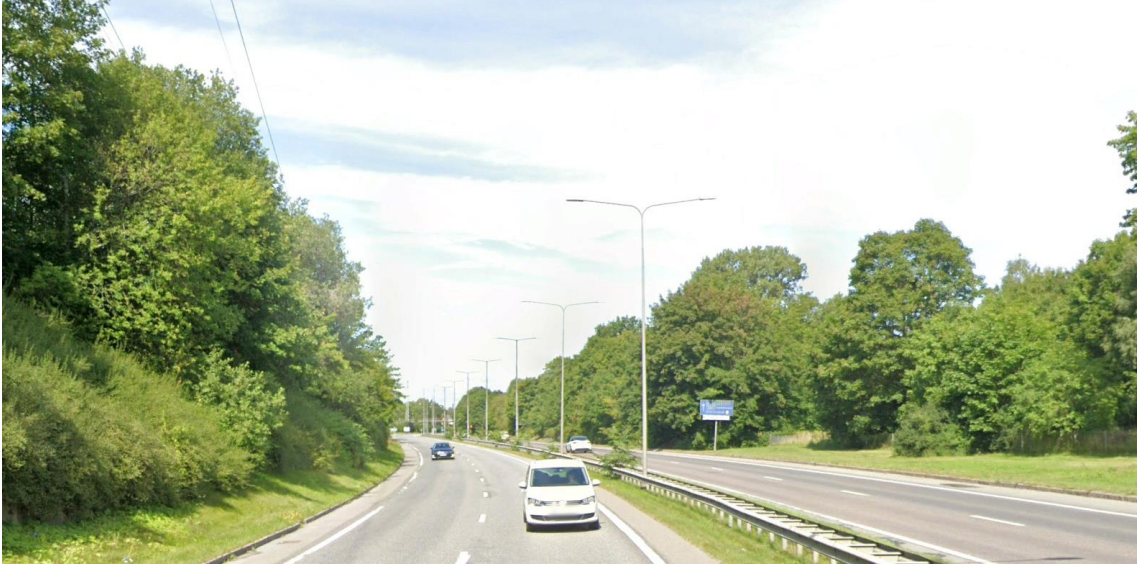
Figur 10, Örbyleden strax norr om tunnelbaneövergången. Alternativ 2 har lokaliserats till Örbyledens västra körfält, till vänster i bild. Foto från Google Earth.
