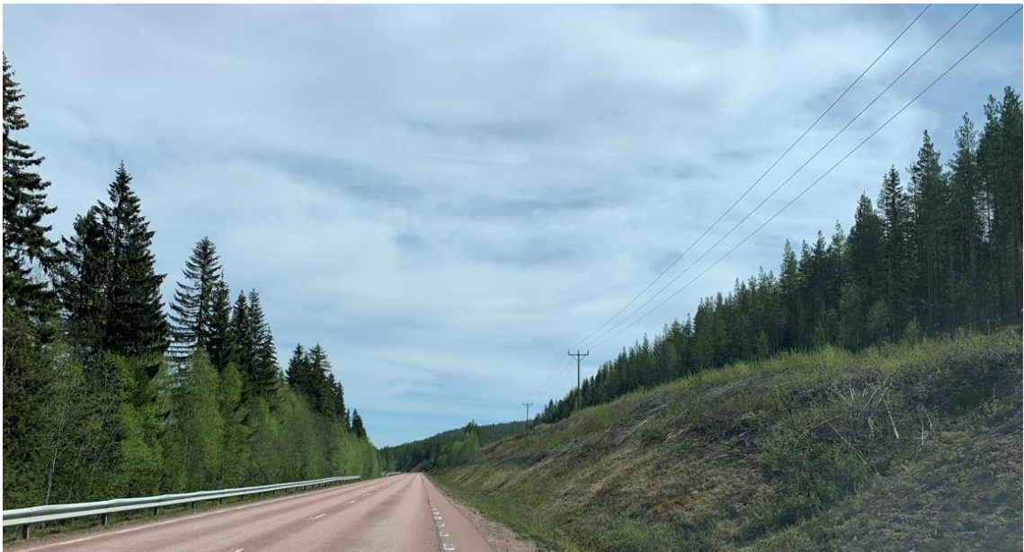
Figur 6. Ledningen passerar söder om Laduön längs väg 70.
